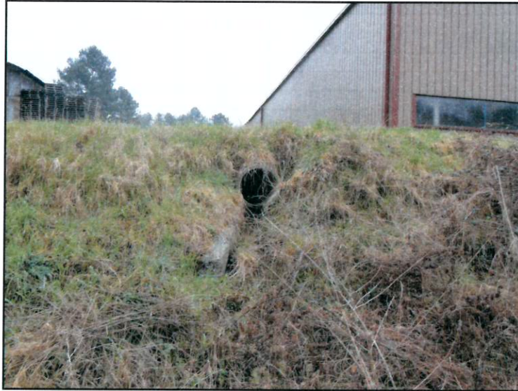
Figure 11 : Fosse située à l'arrière du bâtiment
