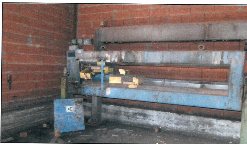
Figure 7 : Dépose des sources radioactives
